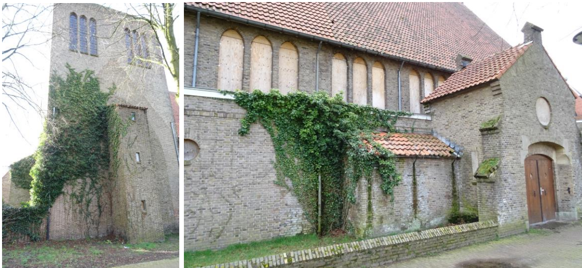
Afbeelding 11 en 12: Aanwezige beplantingen tegen de kerk. Deze plekken kunnen dienen als nestlocatie in het broedseizoen voor verschillende soorten. Bron: R.J.L. Bijvelds 13-03-2020
