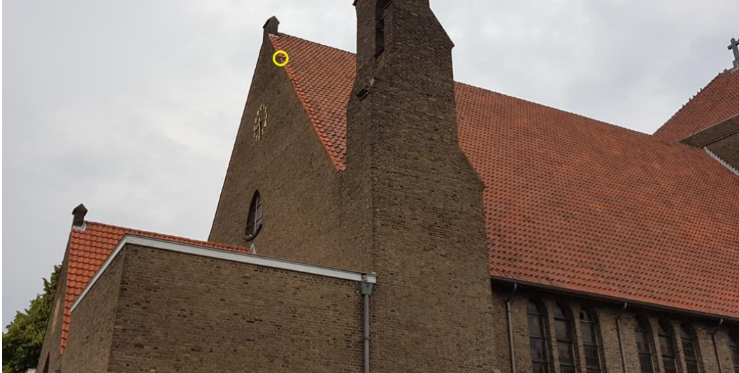
Foto 9. Nestlocatie van gierzwaluw onder het dak van de kerk
