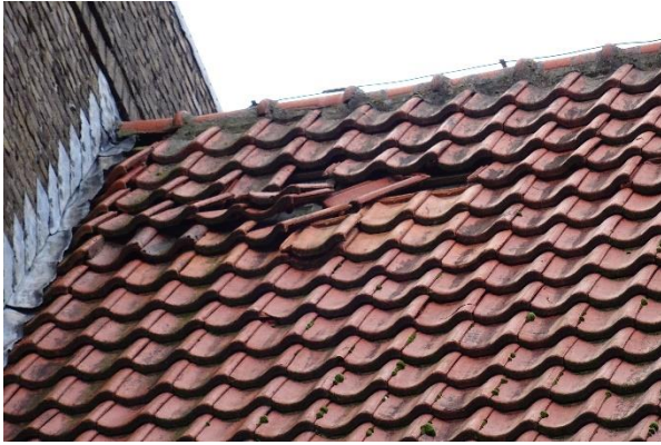
Afbeelding 5 en 6: Gaten in het dak en in de ramen van de kerk waardoor vleermuizen naar binnen zouden kunnen komen. Bron: Rik Bijvelds, 13-03-2020
