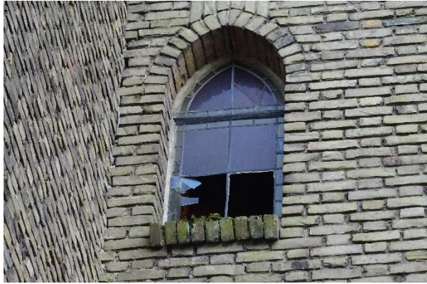
Afbeelding 5 en 6: Gaten in het dak en in de ramen van de kerk waardoor vleermuizen naar binnen zouden kunnen komen. Bron: Rik Bijvelds, 13-03-2020
