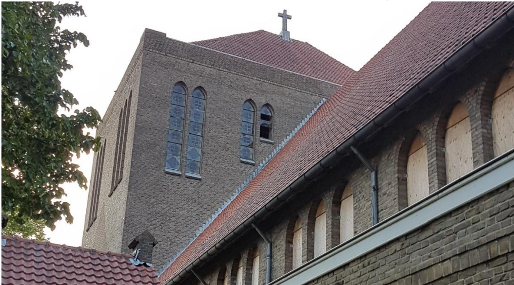
Foto 2. Vierkante toren met kapotte ruiten gezien vanaf de noordwestzijde
