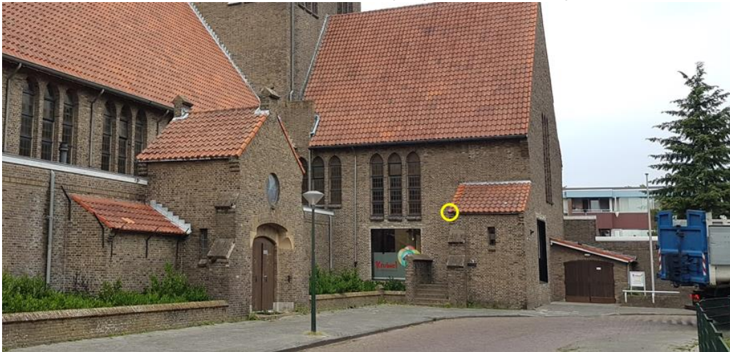
Foto 10. Nestlocatie van gierzwaluw onder het dakje bij het kinderdagverblijf
