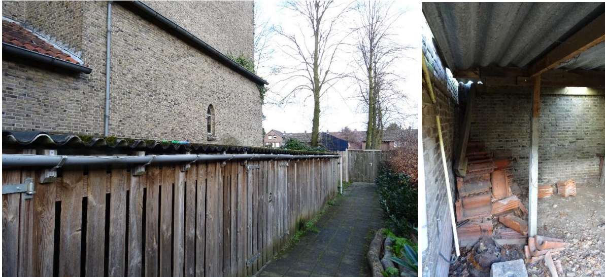
Afbeelding 3 en 4: Golfplaten op balken zonder dakbeschot . Bron: Rik Bijvelds, 13-03-2020
