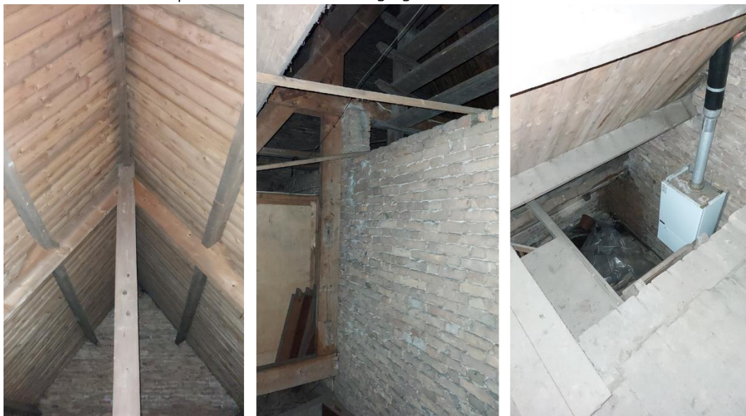
Foto 5. Situatie op de zolder boven de westingang
