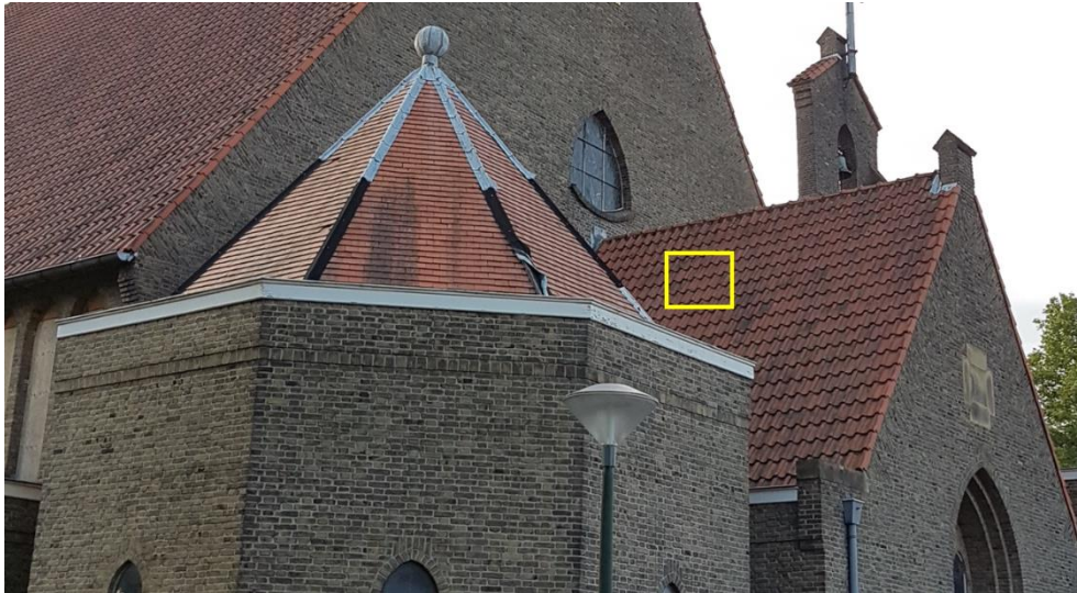
Foto 4. Beoogde locatie van de chiroptière (binnen geel kader) in het dak van de zolder boven de westingang
