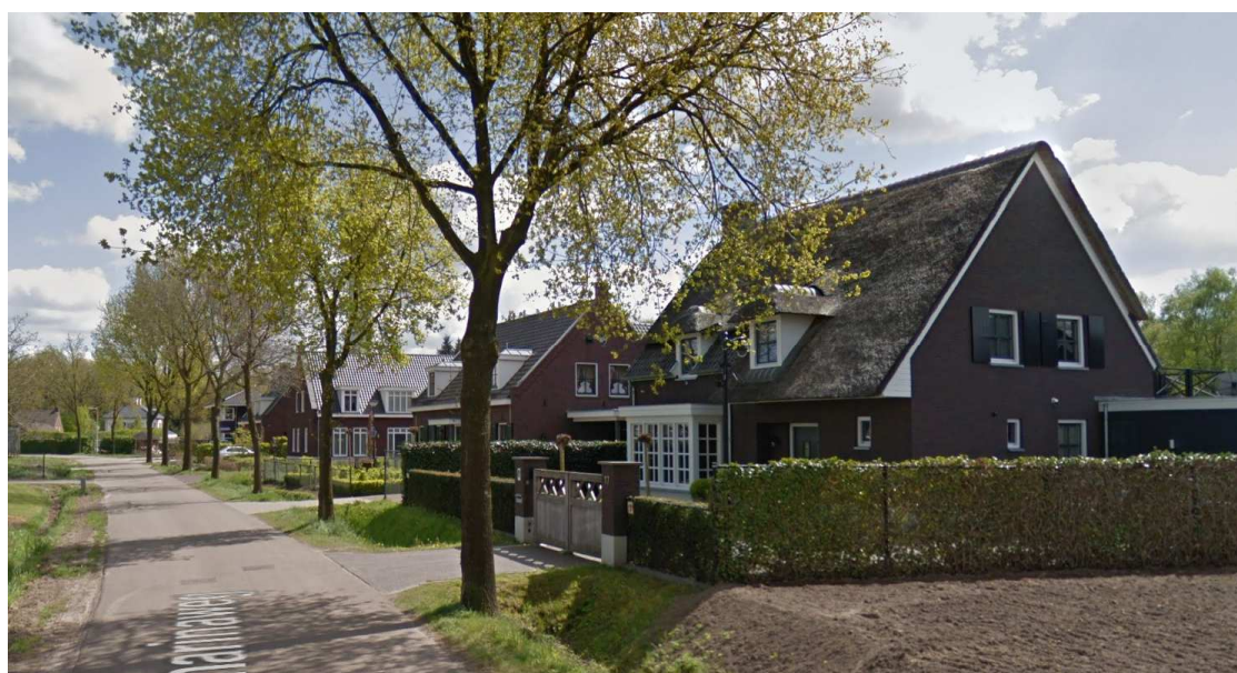
Kenmerkende kapvormen bestaande woningen aan de Sint Catharinaweg
